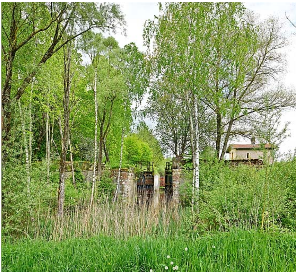
Ecluse n°2, vue depuis le chemin de halage.
