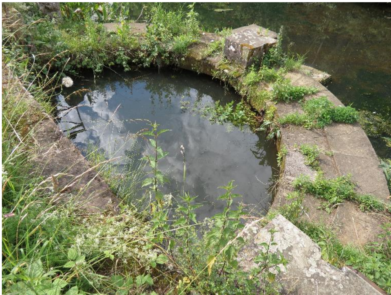
Etang de Gondrexange, déversoir aujourd'hui désaffecté, ensemble trois quarts gauche.
