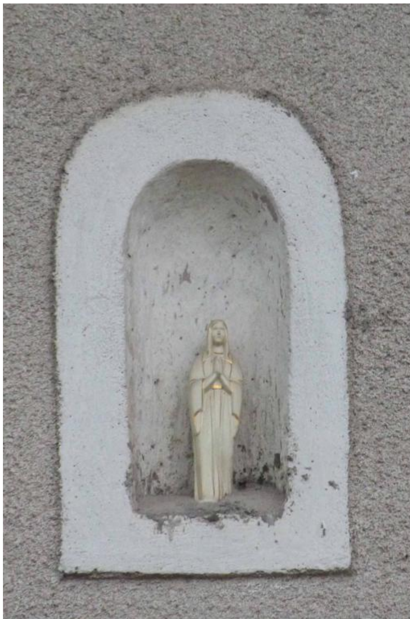
Ferme n°13 de Regney, 296 rue des Fontaines. Vue de détail de la niche au-dessus de la porte charretière en facade antérieure.
