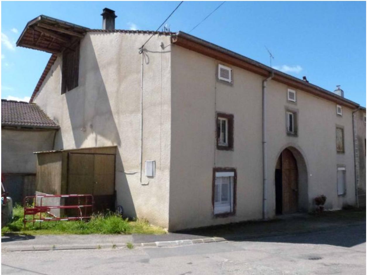
Ferme n°14 de Jorxey, 7 rue de Bellevue. Vue d'ensemble de la facade antérieure de trois quarts gauche.
