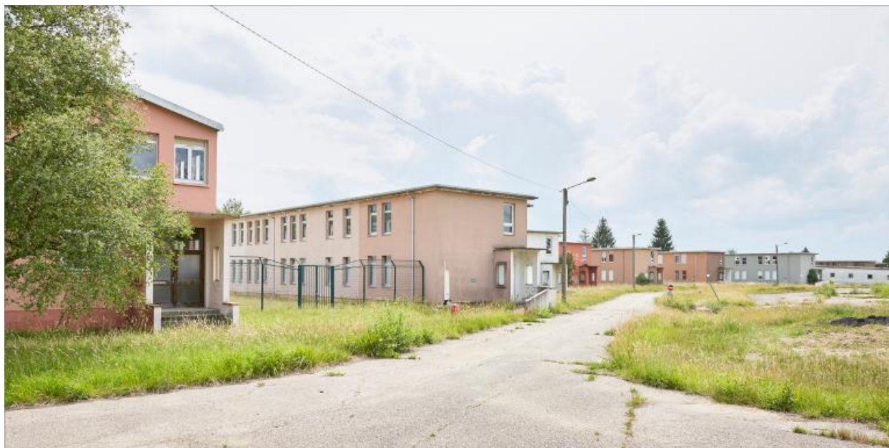
Vue partielle depuis le Nord-Est entre les bâtiments LL (à gauche) et FF (à droite).
