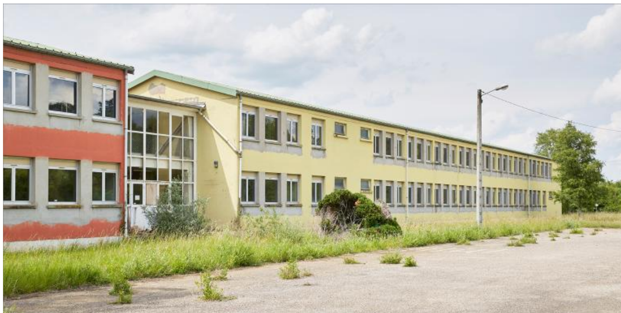
Bâtiment LL, élévation est, ensemble trois quarts gauche.
