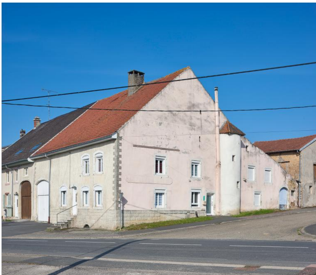
Maison, 12 Grande rue, vue d'ensemble.
