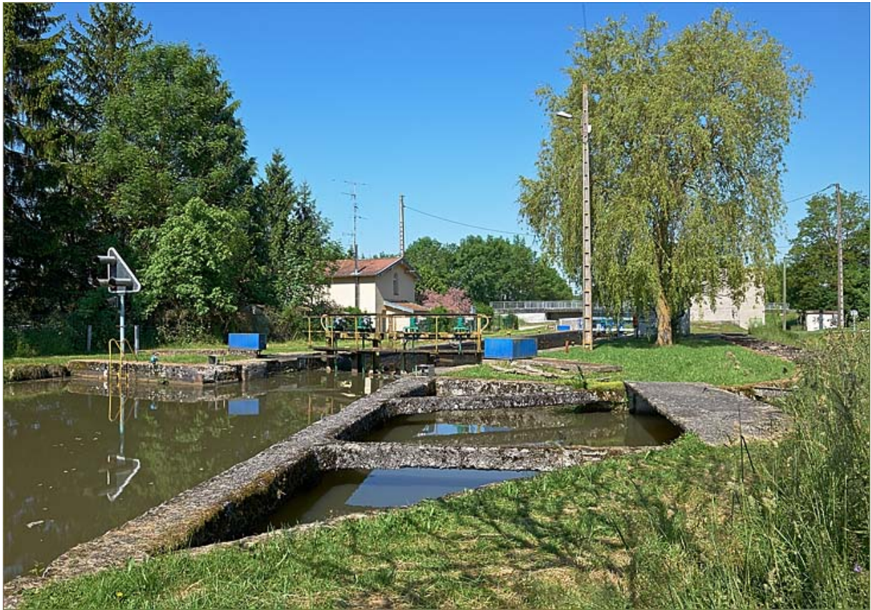
Vue du site d'écluse n°7, ensemble trois quarts gauche.
