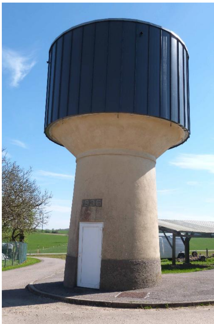
Château d'eau de Chermisey, vue d'ensemble depuis le sud-ouest
