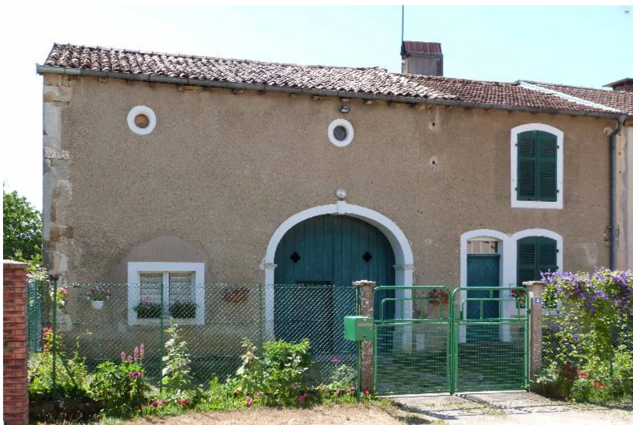
Ferme, vue de la façade antérieure, vue d'ensemble de trois quarts gauche.
