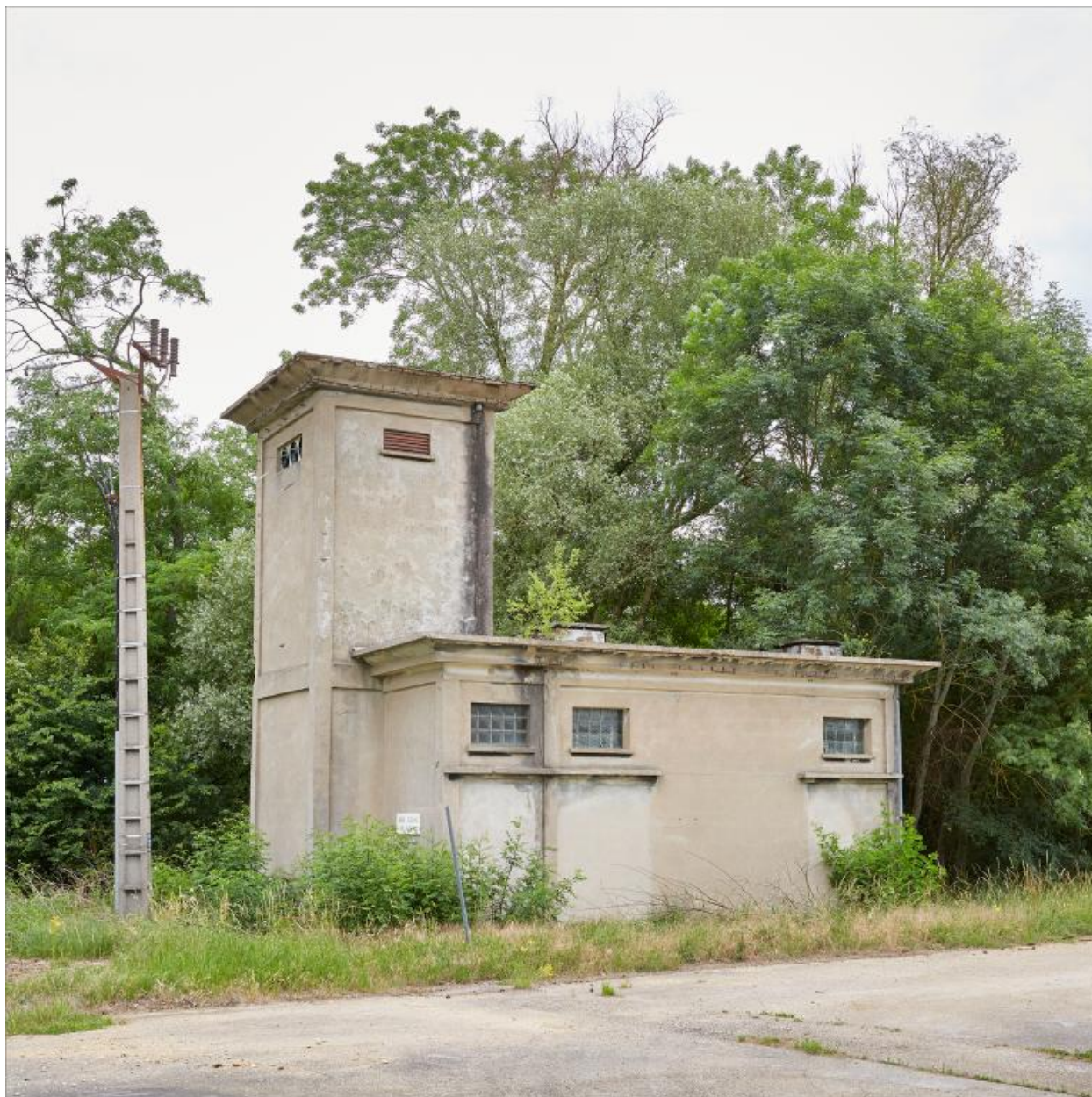
Transformateur U, ensemble depuis le Sud-Ouest.
